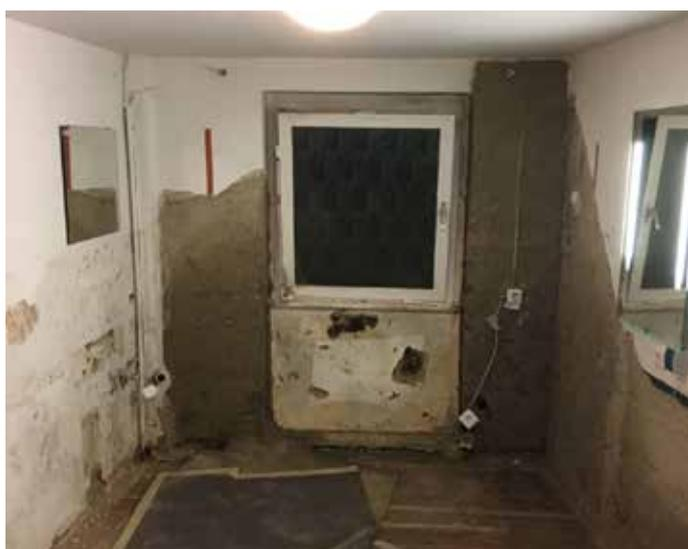
So wurden in beiden Räumen die uralten, dafür gefühlt dreifach verklebten Teppiche herausgerissen. Es folgten der Putz sowie sämtliches Möbilar und Inventar. Als dies alles offen lag, wurde entschieden, die Stromversorgung komplett zu erneuern.
